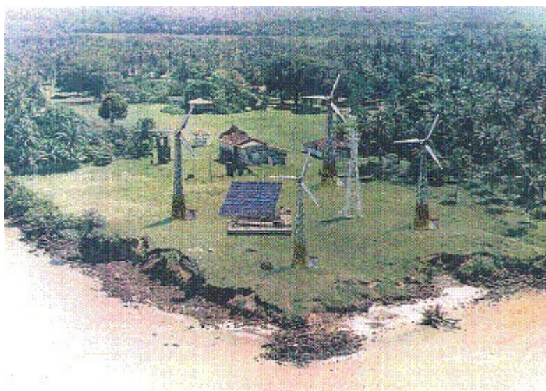
Figura 7.3 - Montagem do sistema híbrido de Joanes.
