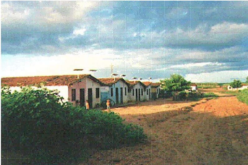
Figura 7.2 - Sistemas fotovoltaicos em casas geminadas no município de Pentecoste – CE.
